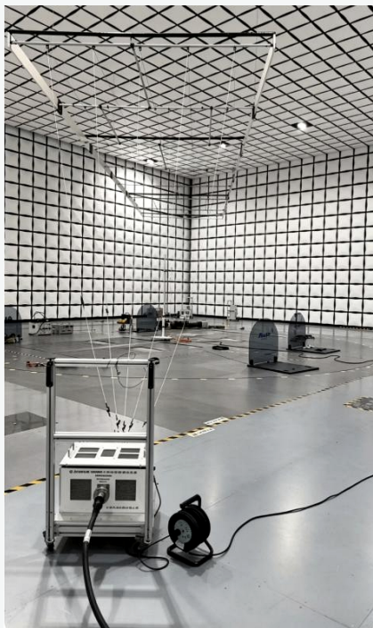
现场部署 / 14 米系统
